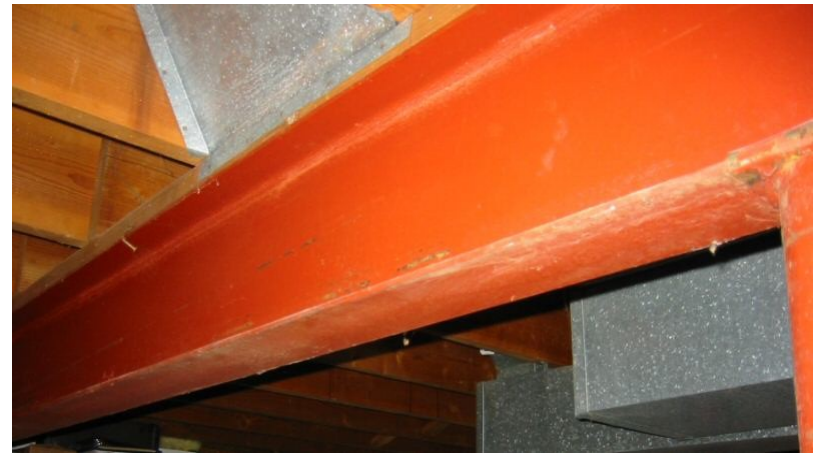
Nosník z ocele – stropnice v domě
