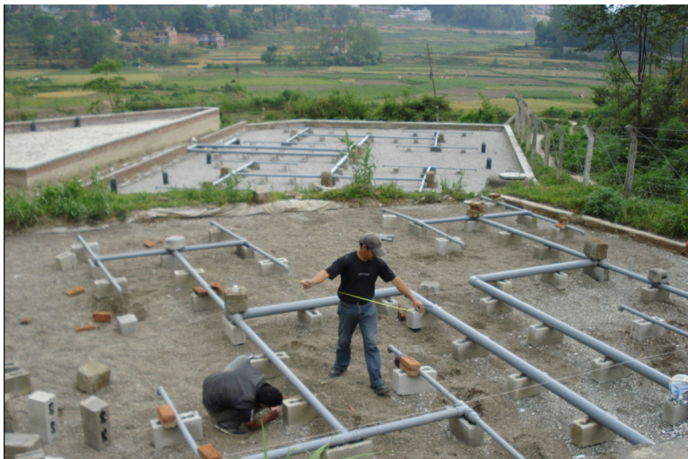
výstavba kořenové čistírny v Nepálu
