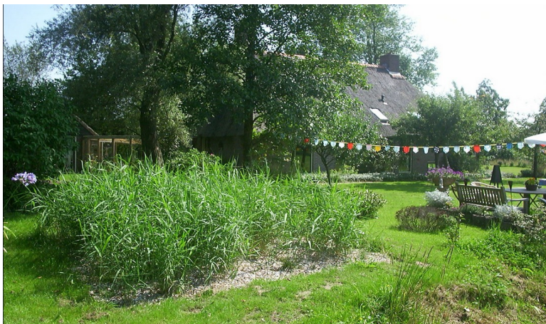
domácí kořenová čistírna odpadních vod v Nizozemsku
