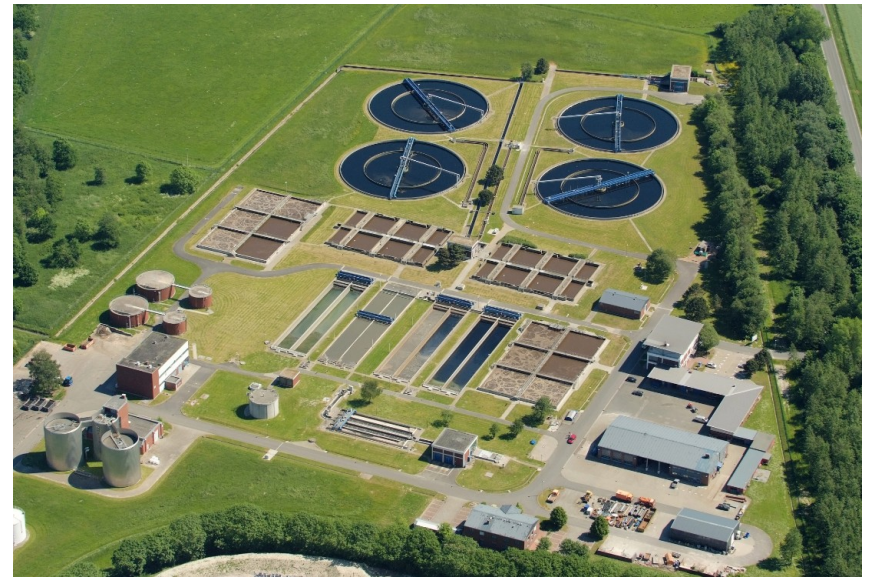
Čistírna odpadních vod v Německu, Wilhelmshavenu
