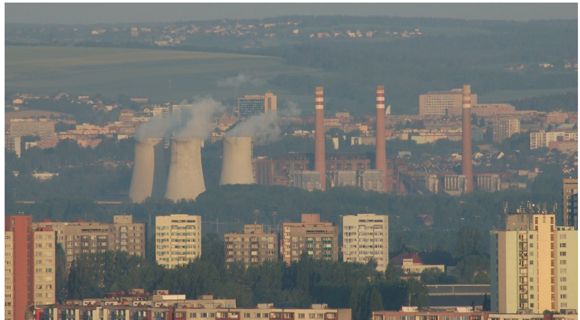
Elektrárna Třebovice v Ostravě
