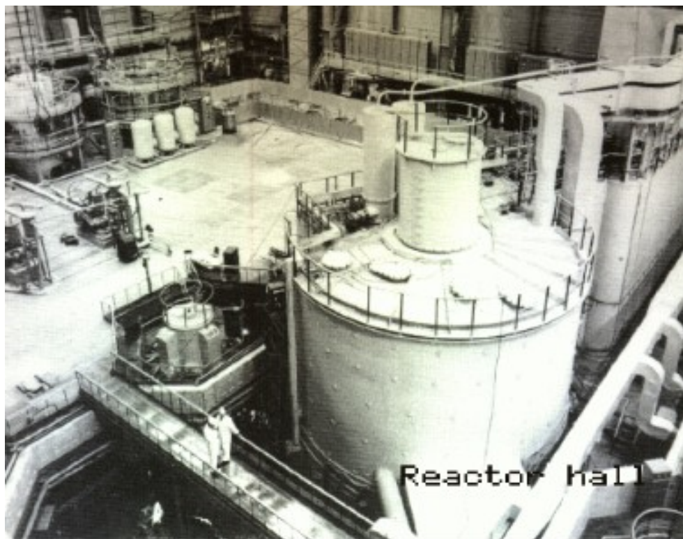
Reaktorová hala jaderné elektrárny a odsolovací stanice Ševčenko (u Kaspického moře), princip reverzní osmózy
