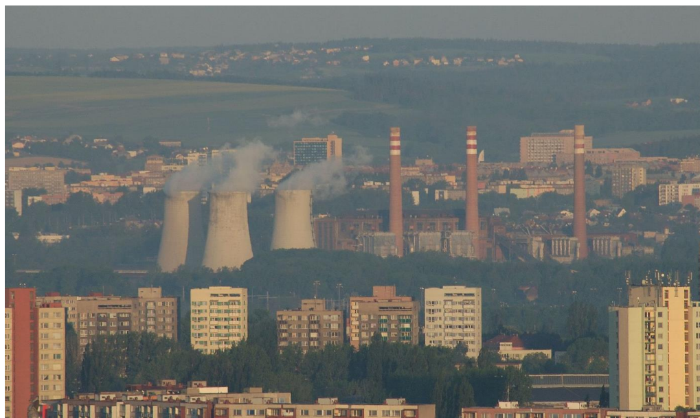
Elektrárna Třebovice v Ostravě
